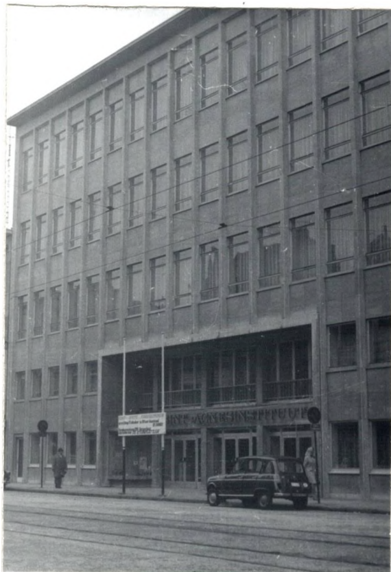
Photograph 2: Technisch Instituut Sint Agnes Antwerp, Belgium
